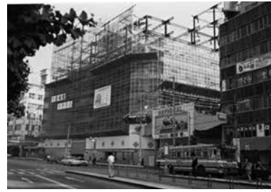
1971年 新世界会館建築の様子
